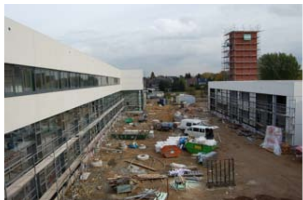
Der künftige Betriebshof der HFRW
