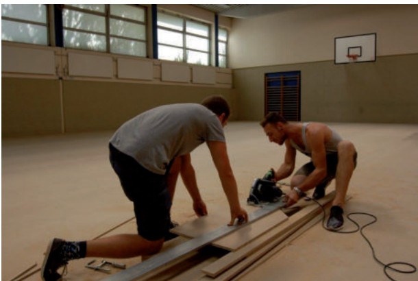
Einbau eines Bodens
